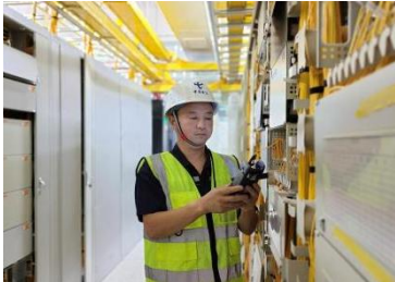
检测通信机房设备
