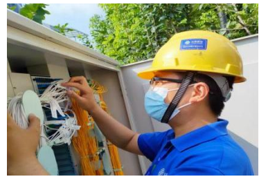
检修通信设备
