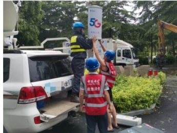
维修通信基站线路
